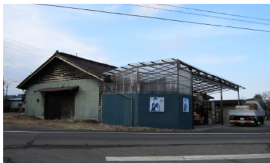
株式会社 松見 塩尻倉庫外観
