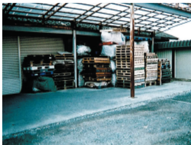
株式会社 松見 塩尻倉庫外観
